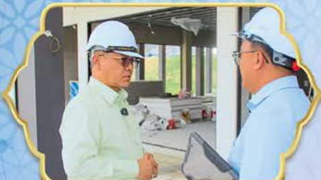
LAWATAN KERJA RASMI MENTERI DI JABATAN PERDANA MENTERI (HAL EHWAL AGAMA) KE TAPAK PEMBINAAN IKMAS FASA 2
